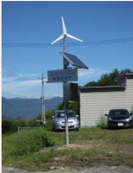
駐車場看板との併用 主材質：SUS304 アスト：101.6φ 制御BOX： 縦600×横500×厚250
